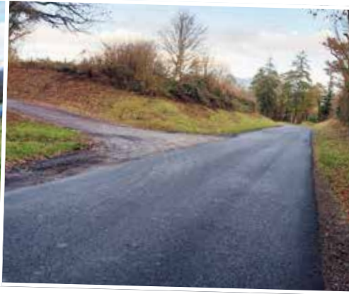
Reprise de la route de Crédoz par la communauté de communes en enrobé à l'émulsion
