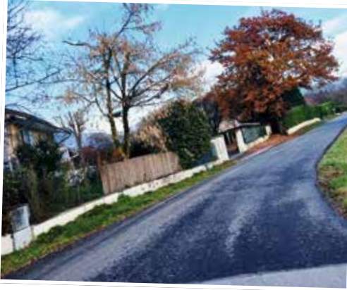
Reprise de la route de Crédoz par la communauté de communes en enrobé à l'émulsion
