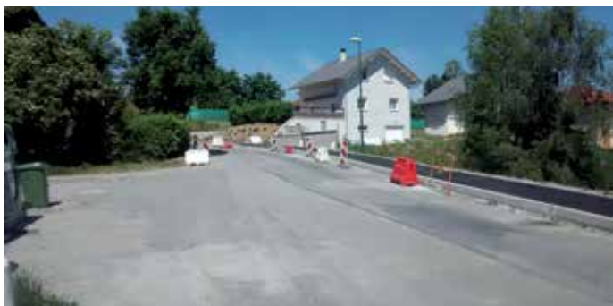
Création d'un trottoir
