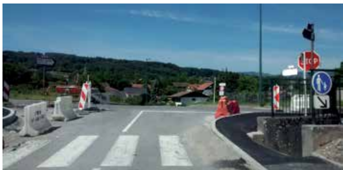
Entrée de la route de Loisinges élargie
