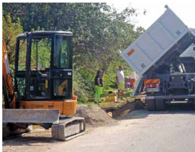
Travaux d'assainissement à Chevrier
