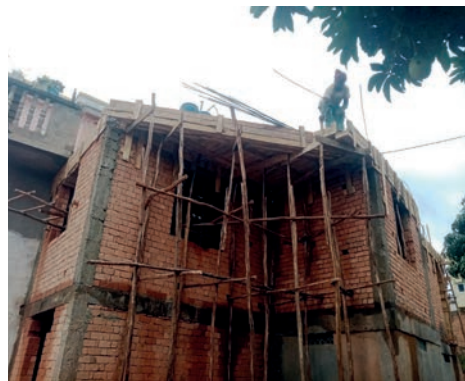
Construction d'un cabinet médical
