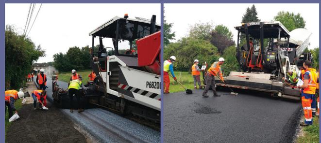
L'empreinte carbone de Biophalt est neutre, grâce à l'emploi de coproduits issus de la filière sylvicole et à sa fabrication en process tiède.
