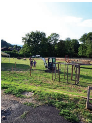
La mise en place des piquets de clôture...
