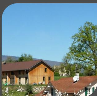
"Revêtement extérieur ou paroi sans ouvertures, sous le toit, fixé sur l'ossature, qui a pour fonctions l'esthétique et la protection du bâtiment", l'habillage bois doit être choisi en accord avec les façades et les menuiseries, dont il peut être de même teinte, plus foncé ou équivalent à la valeur (luminosité).
