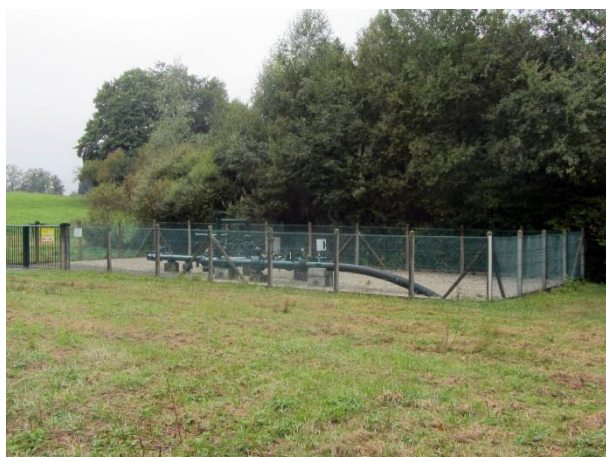
Poste de gaz à du Beulet
