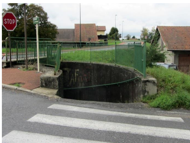
Passage piéton sous la RD2
