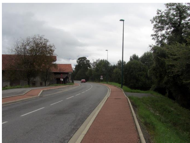
Trottoirs aménagés le long de la RD2 et dans le chef-lieu
